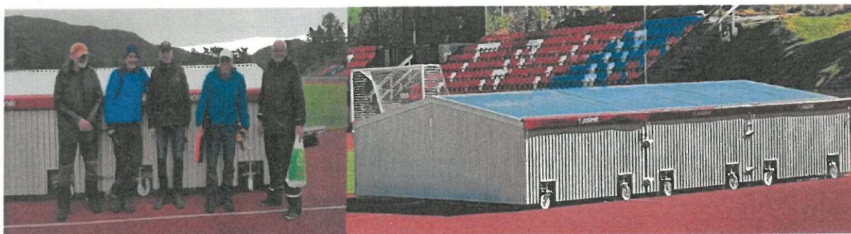
Dugnadsgjengen som monterte takoverbygga. Til høgre sluttresultatet (bygget over stavmatta).
